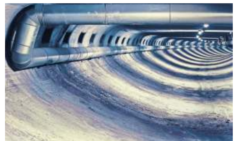
Platz für Abluft: der Luftkanal unter dem Stuttgarter Wagenburgtunnel
